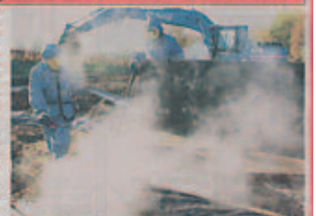
Stichting AAP is afgelopen week gestart met de sanering van het terrein dat met de schadelijke wasbeerspoelworm is besmet. De besmette grond is afgegraven en verpakt in bigg, waarna onder druk stoom met temperaturen van boven de honderd graden door de grond wordt geblazen. Foto: Postbode
