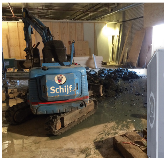
Springen in betonvloeren van 35 cm dik t.b.v. nieuwe roltrappen, vides en trappenhuizen.
