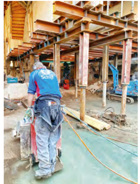
Inzagen en afvoeren bestaande betonnen souterrain
