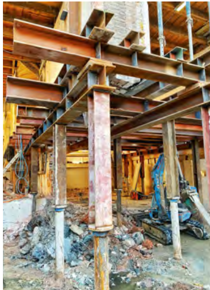
Tafelconstructie op nieuwe schroefinjectiepalen geplaatst om beide panden op te vangen
