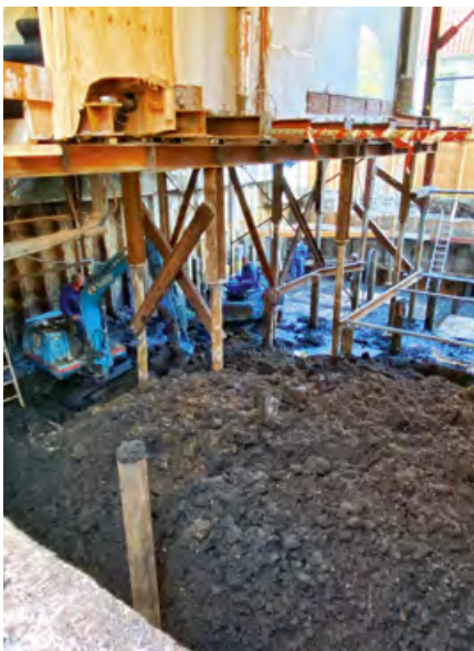
Ontgraven en damwand aanbrengen
